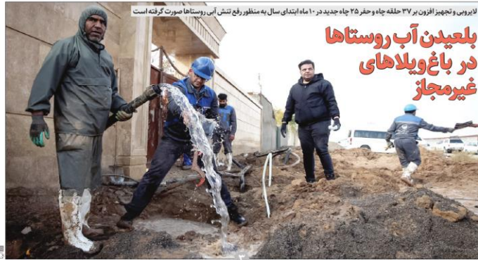
لایروبی و تجهیز افرون بر ۳۷ حلقه چاه و حفر ۲۵ چاه جدید در ۱۰ ماه ابتدای سال به منظور رفع تنش آبی روستاها صورت گرفته است
